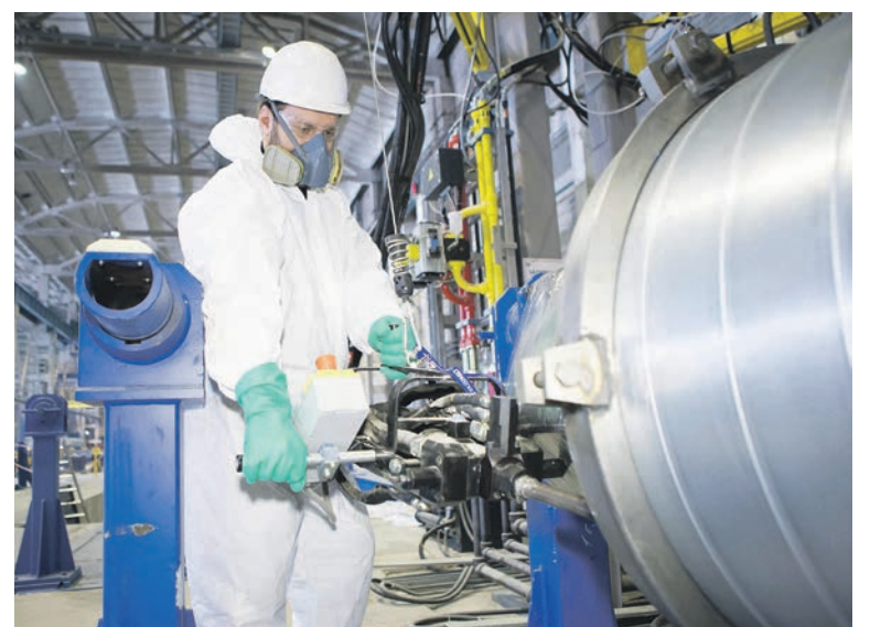
▲ Качество будущей изоляции зависит от заливки © ВАЛЕРИЙ ПОКУМЕЙКО
